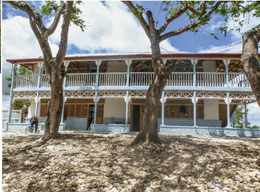
**Haiti:** Die Ausführung der Schule erfolgte in gemischter Holz-Lehmbauweise (Holzfachwerk mit Ausfachung in Lehmziegeln). Das Gebäude ist erdbebensicher erstellt.
